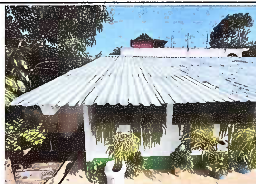
Módulo 1: Sustitución de algunas laminas de aulas
