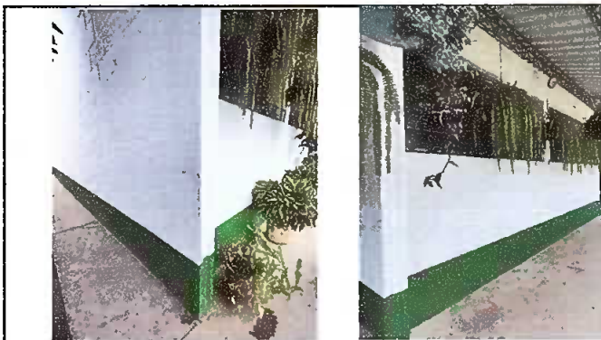
Módulo1:Pintura en muros exteriores e interiores
