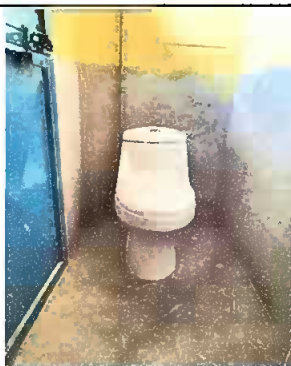
Módulo 2: Sustitución inodoro
